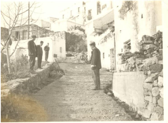
11 Ο Σταθάκης επιβλέπει τη τσιμεντόστρωση του δρόμου στο Γκισιμέ.
